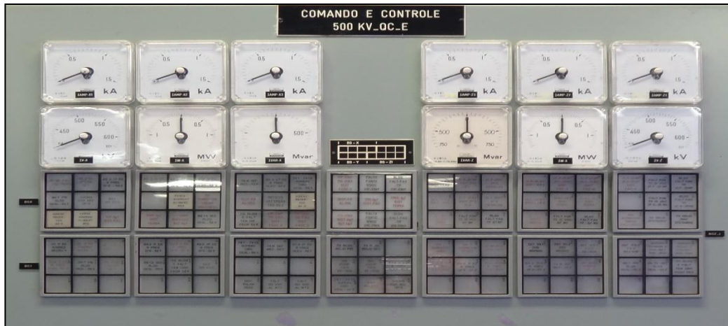
Figura 4.3 – Instrumentos analógicos de medição e anunciadores de alarme.
