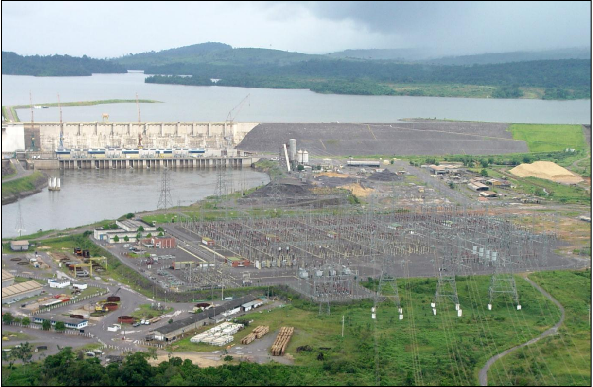
Figura 4.1 – Subestação Tucuruí - SE TC.
