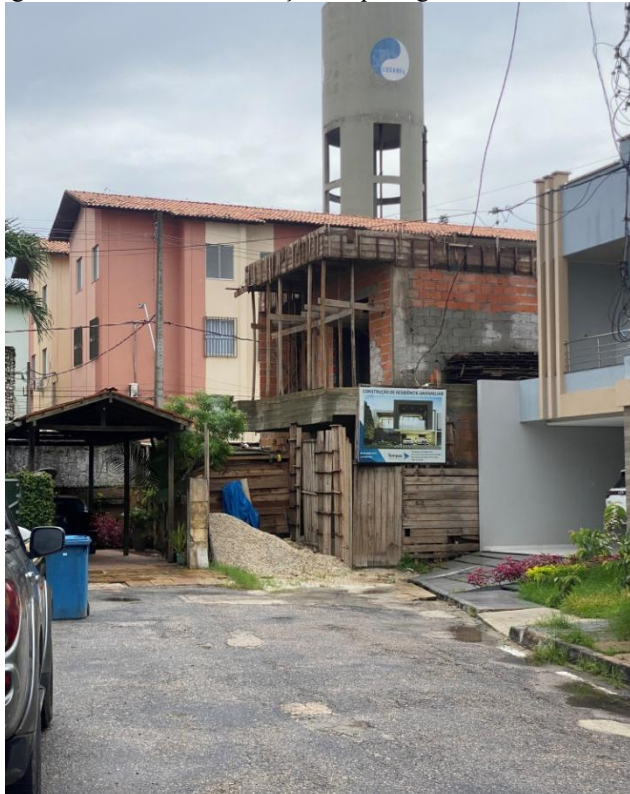
Figura 36: Casa em construção, o que significa novo morador.
