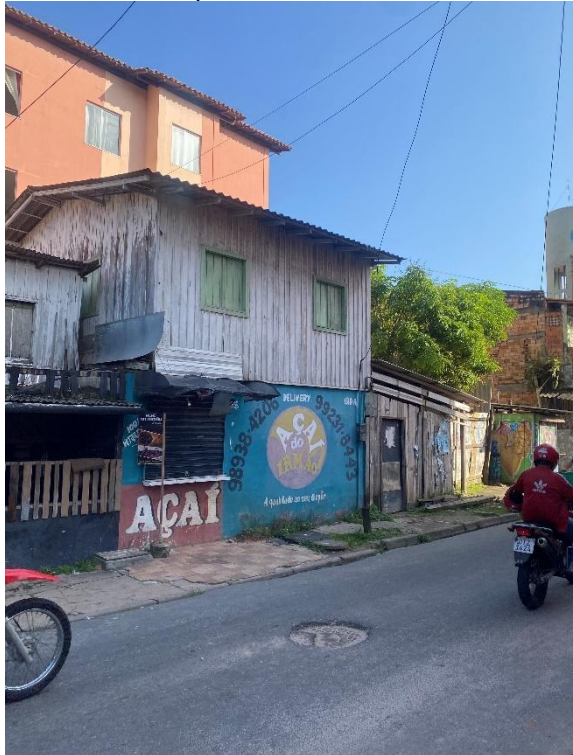
Figura 35: Moradia típica do entorno imediato, na rua Olaria.
