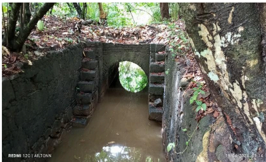
FIGURA 4. Calha um canal feito todo de pedra para armazenar água usado na olaria quando a maré estivesse seca. Fonte: O Autor (2024).
