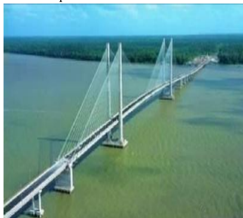
Fotografia 17 – Complexo Viário sobre o Rio Guamá - Alça Viária.
