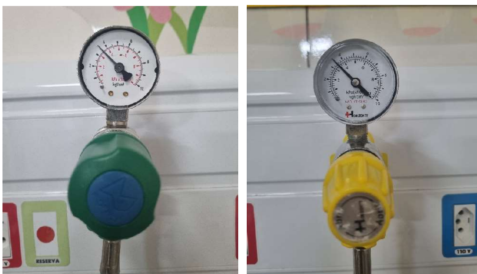
Figura 28 – Verificação da pressão da rede de gases medicinais antes da montagem do circuito respiratório.
