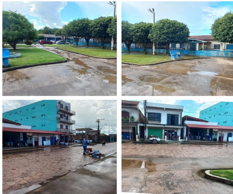
Figura 05: Area central do bairro nova Cameté: Rua Valda valente/ Praça/ Escola Santa Terezinha.
