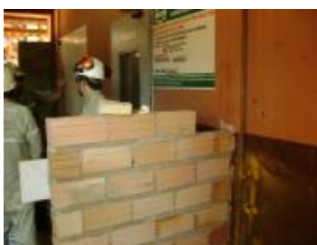
Figura 49 – Remodelação dos banheiros da área de beneficiamento de minério
