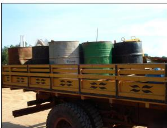
Figura 32 - Transporte de entulho da construção civil.
