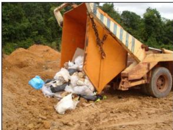
Figura 65 - Descarte de resíduos para aterramento.
