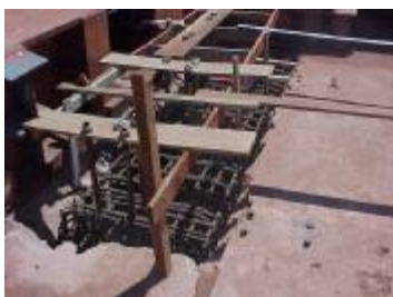
Figura 45 – Construção de base para estruturas do porto Fonte: Durante visita as obras de Porto Trombetas
