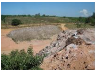
Figura 21 – Exemplo: Célula para aterro de construção civil
