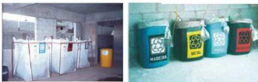
Figura 15 – Exemplo: Acondicionamento adequado de RCC
