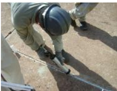
Figura 54 – Impermeabilização onde estão instaladas as tancagens de óleo diesel.
