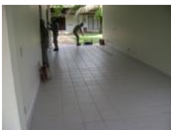
Figura 51 – Reforma dos alojamentos da área do porto
