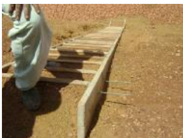
Figura 52 – Construção escadas para acesso aos tanques de rejeito de minério
