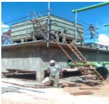
Figura 44 – Construção da torre de resfriamento da usina termoelétrica Fonte: Durante visita as obras de Porto Trombetas
