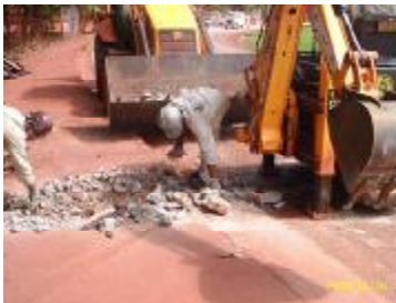
Figura 53 – Demolição de calçada e asfalto para interligação de tubulação.
