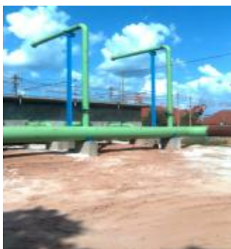
Figura 47 – Construção de bases para tubulações novas da Usina termoeletrica
