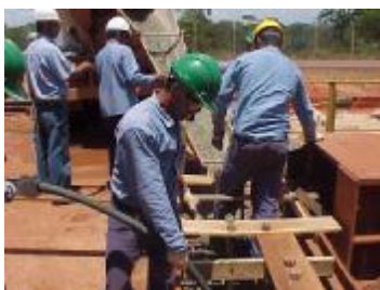
Figura 43 – Construção de base para repotenciamento do empurrador de vagões
