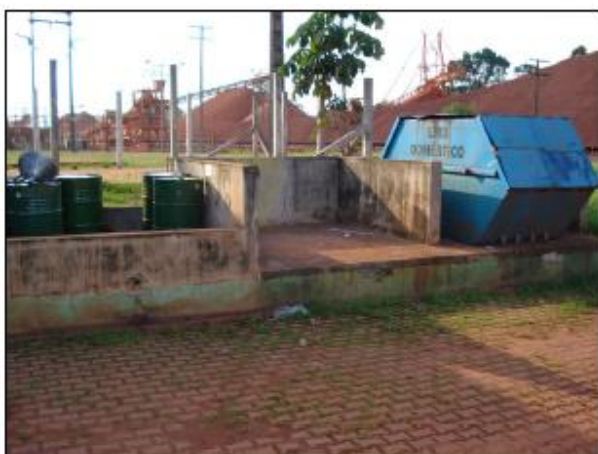
Figura 31 - Área de caçambas de lixo seco e óleos.
