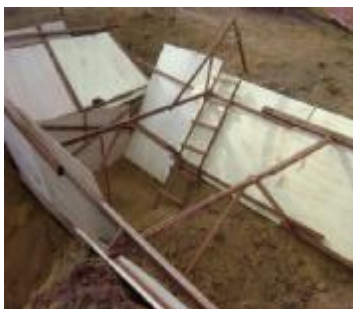
Figura 46 – Construção caixa de passagem para rede de esgoto da mina Fonte: Durante visita as obras de Porto Trombetas
