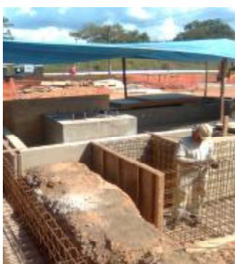
Figura 48 – Construção de uma subestação na área do porto
