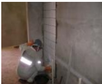
Figura 50– Reforma dos banheiros dos alojamentos da mina
