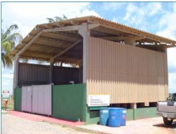
Figura 16 – Exemplo: Depósito de Armazenamento temporário de resíduos perigosos – NBR 12.235(1992)
