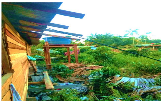
Figura 23 - Caixa d'água no alto 1.000 litros
