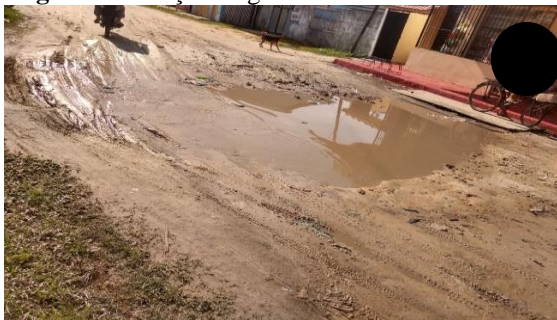
Figura 26 - Poça de água na rua Sebastião Amado
