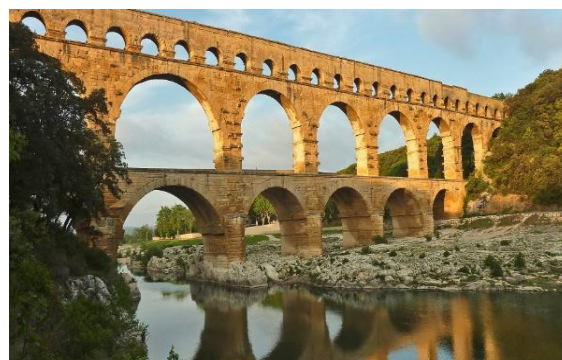
Figura 3 - Aqueduto no Sul da França
