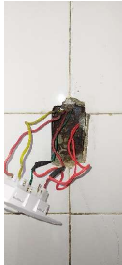
Figura 2 – Circuitos da tomada do ferro de passar
