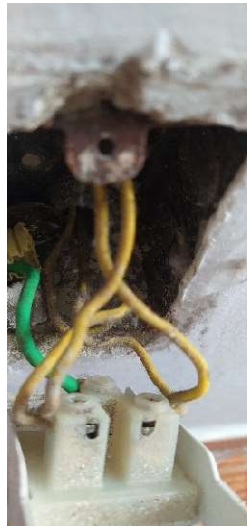
Figura 5 – Circuito da tomada aterrada no Quarto 3
