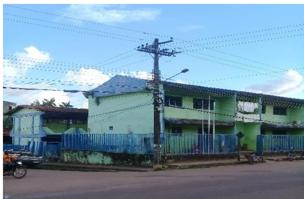
Figura 1: EMEF PINTO MARQUES (vista lateral e frontal)
