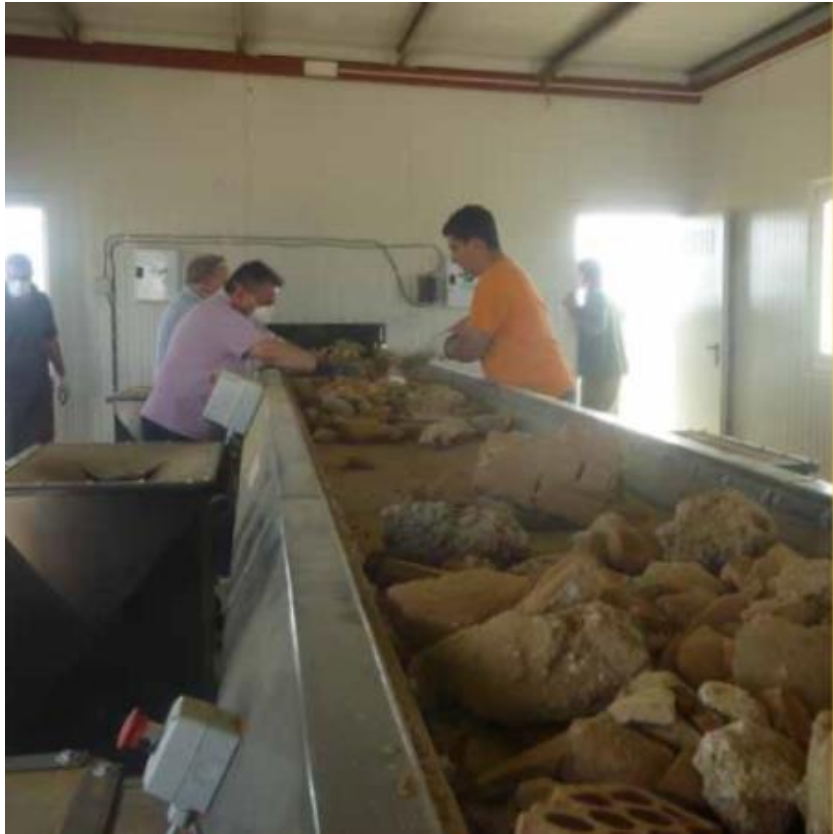
Figura 9: Esteira de Triagem (Picking Station)
