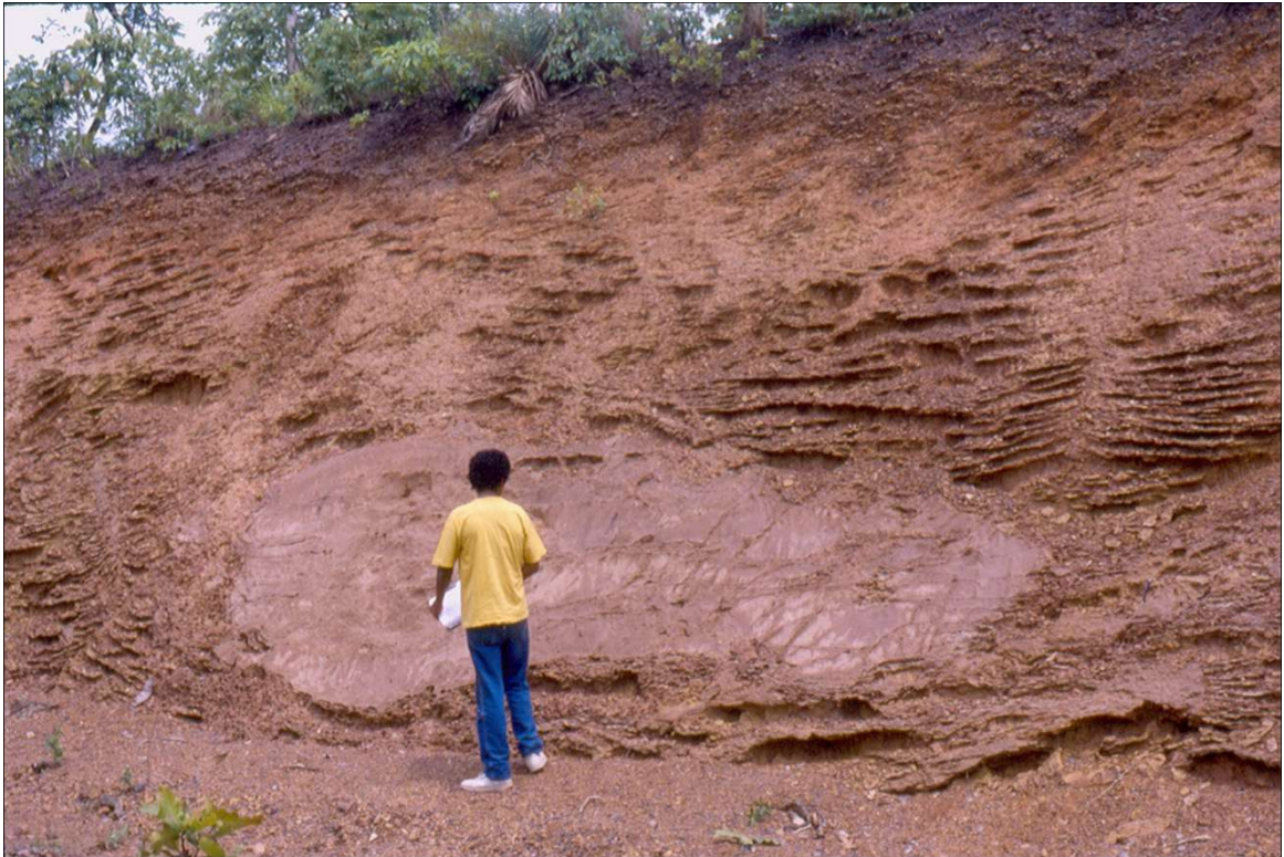
Figura 14: Foliações subhorizontais contornando bloco de arenito métrico e fraturas subverticais cortando os planos de foliação, presentes no diamictito cisalhado da Formação Cabeças (9000553E/0181701N).
