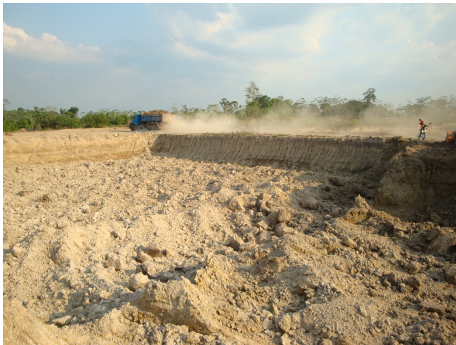
Figura 11 – Poluição atmosférica com suspensão de partículas finas causadas pelo transporte de máquinas pesadas.
