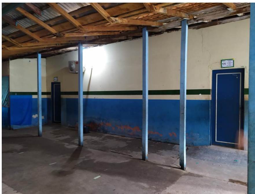
Construção da biblioteca
