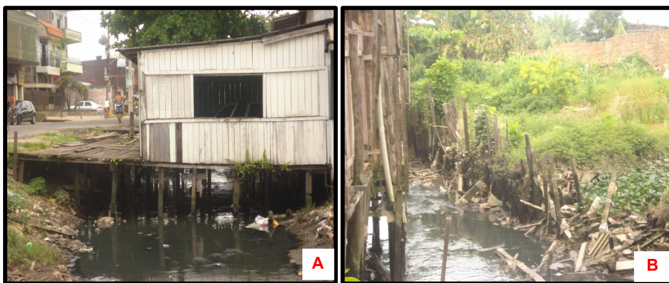
Figura 6 (A e B) - Identificação de moradias (palafitas) existentes na Rua Bernardo Sayão, bairro da Condor.
