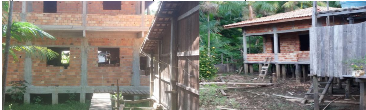
Figura 12- Casarões de alvenaria em construção na comunidade de Curupitomba.
