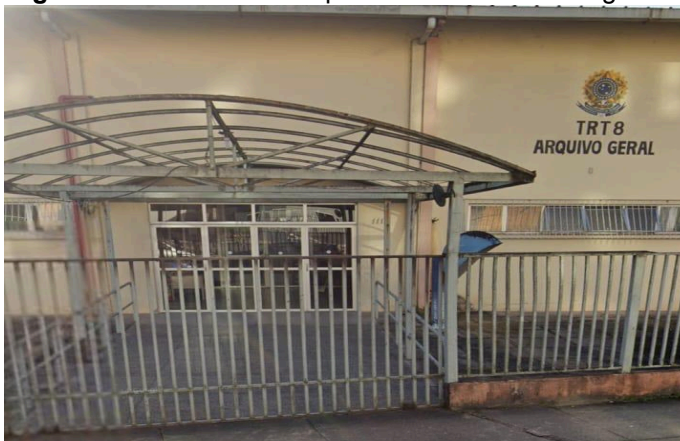
Figura 1 – Fachada do Arquivo Geral do TRT-8 região
