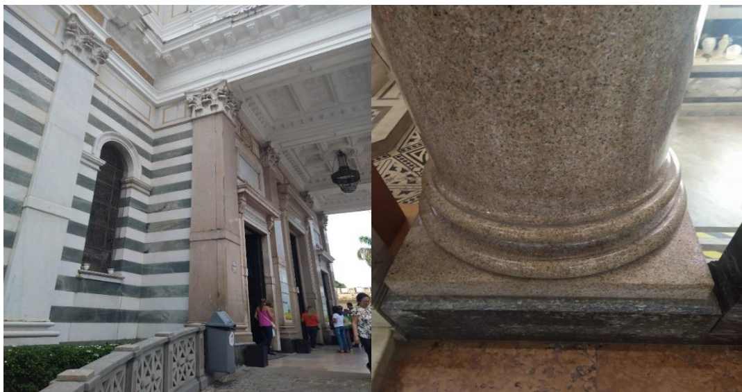
Figura: 05 – Basílica Santuário Nossa Senhora de Nazaré – à esquerda, parte da faixada frontal com elementos polidos – à direita, pilar trabalhado em mármore vista interna.
