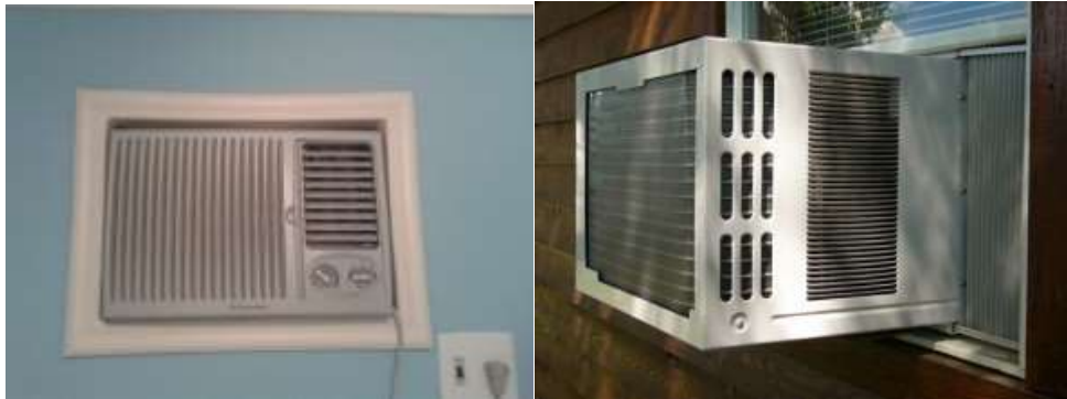
Figura 6. Condicionador de ar tipo janela: À esquerda, parte interna; à direita, parte externa
