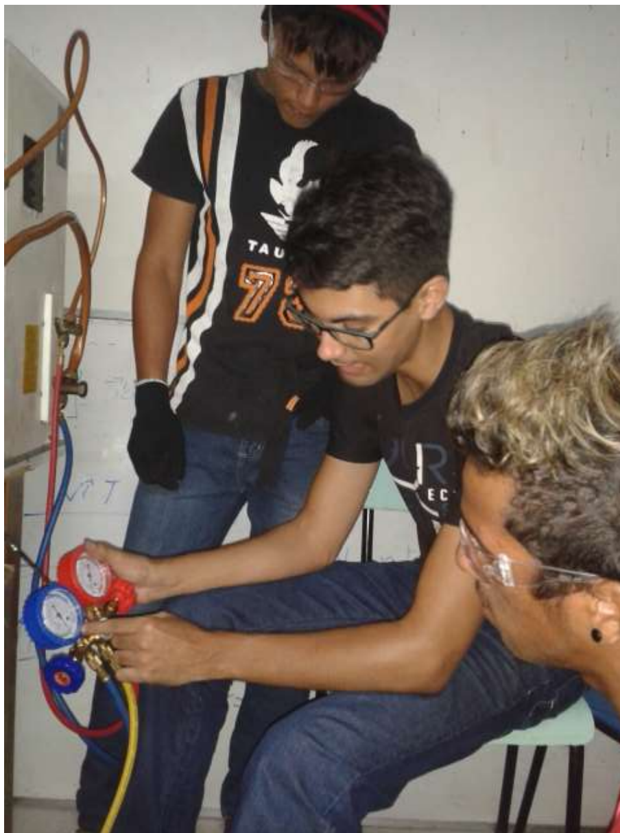
Figura 14. Inserção de fluido refrigerante realizada com auxílio do instrutor do curso.
