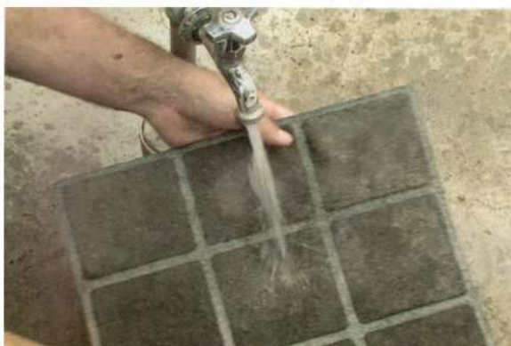
Figura 1. Filtro de ar sendo lavado.
