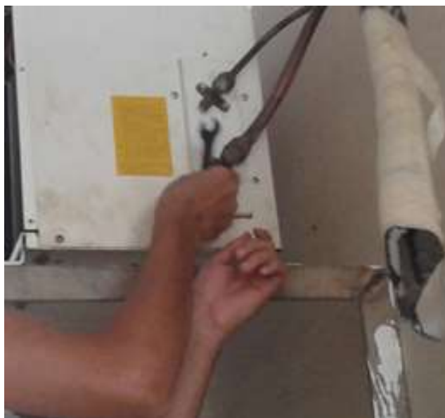
Figura 3. Fixação da tubulação da unidade evaporadora a unidade condensadora.
