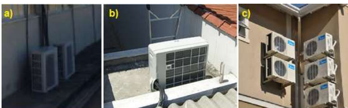
Figura 1. Unidades condensadoras Split instaladas: a) No nível do solo; b) Sobre um telhado; c) Fixados na parede.
