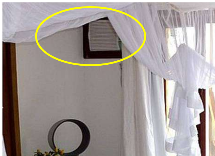
Figura 2. Posicionamento errado do condicionador de ar em relação aos obstáculos (cortina).
