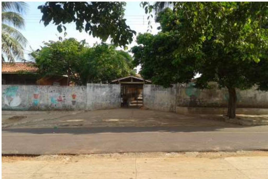
Figura 1. Vista da Escola Municipal de Ensino Fundamental Maria Fernandes de Medeiros Alves.
