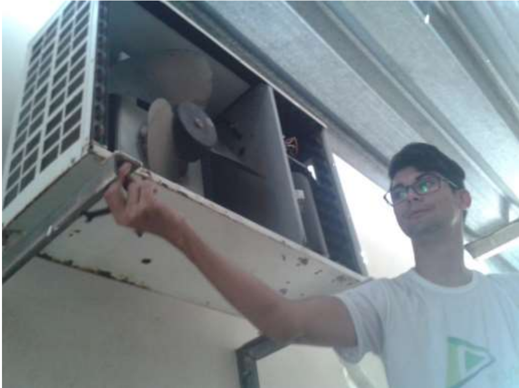
Figura 3. Remoção do equipamento de ar condicionado Split.
