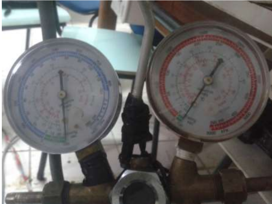
Figura 6. Verificação do vácuo sendo analisado pelo manifold.
