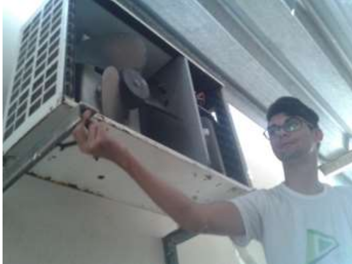
Figura 2. Fixação da unidade condensadora ao suporte.
