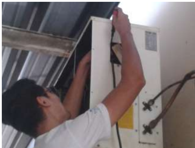
Figura 4. Colocação do fio aos terminais elétricos
