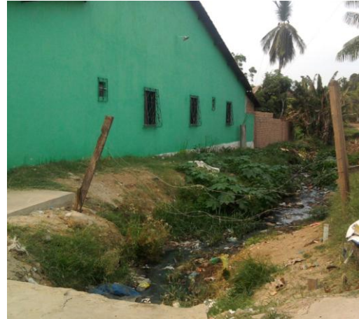
FIGURA 04- Vala sanitário na Rua Santa Terezinha em Santa Inês -MA
