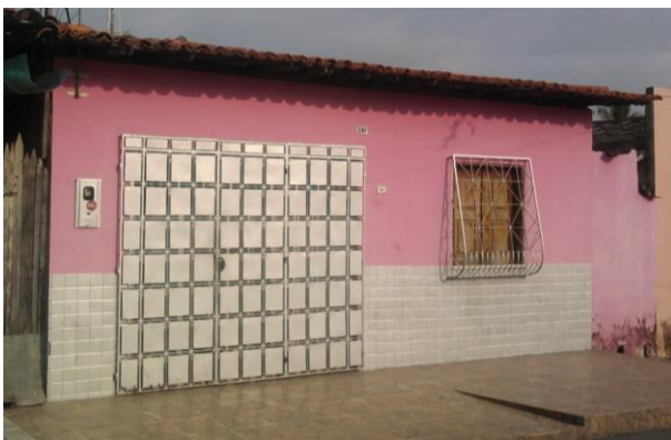
FIGURA 18 - Fachada típica de residências em Santa Inês – MA
