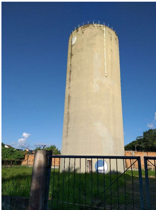
Figura 28 - Reservatório Elevado Cristo Redentor
