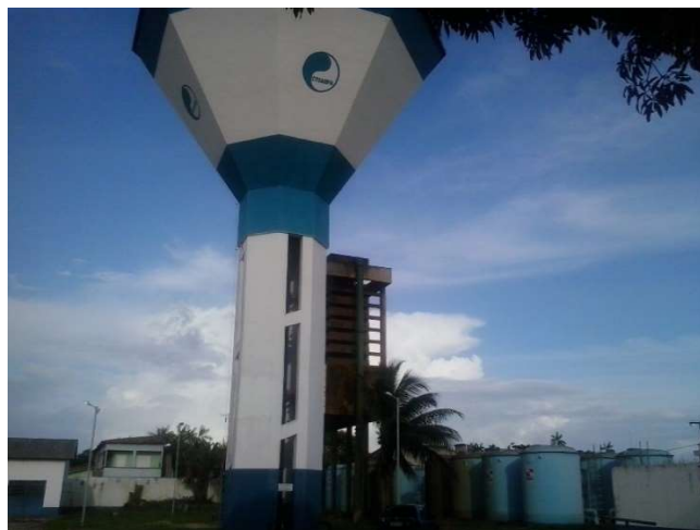
Figura 27 - Reservatório Elevado ETA
