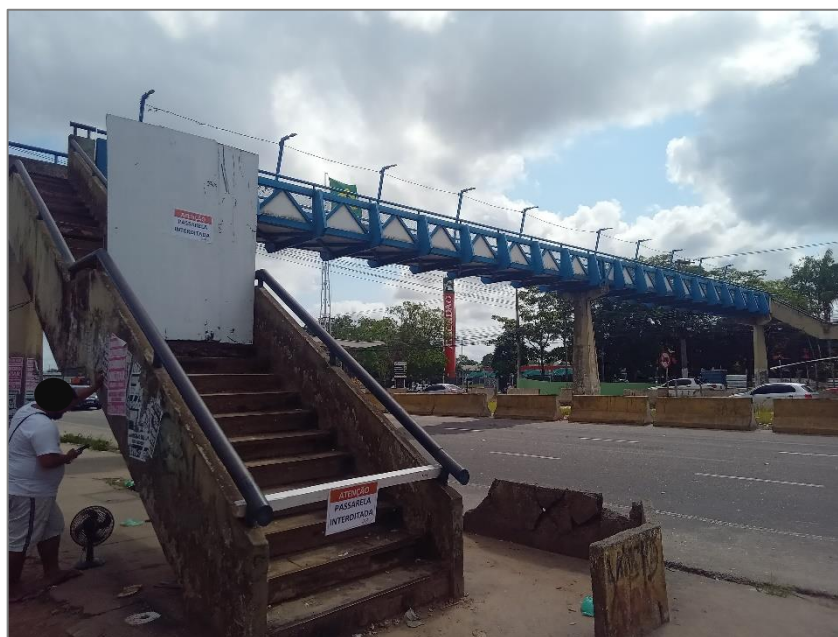
Figura 6 - Antiga passarela de Ananindeua
