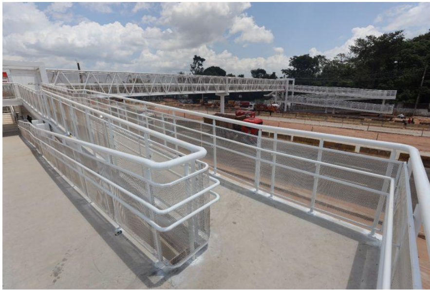
Figura 17 - Nova Passarela instalada
