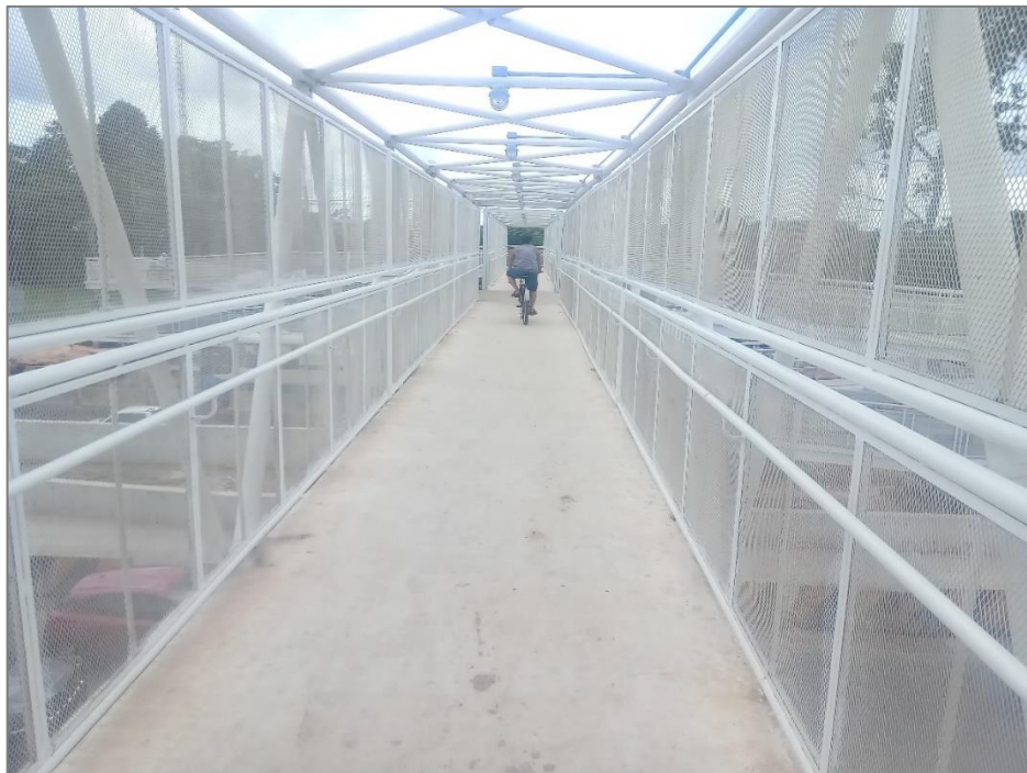
Figura 20 - Nova Passarela instalada (4)
