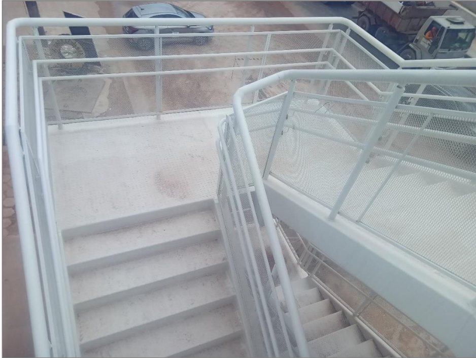
Figura 21 - Nova Passarela instalada (5)
