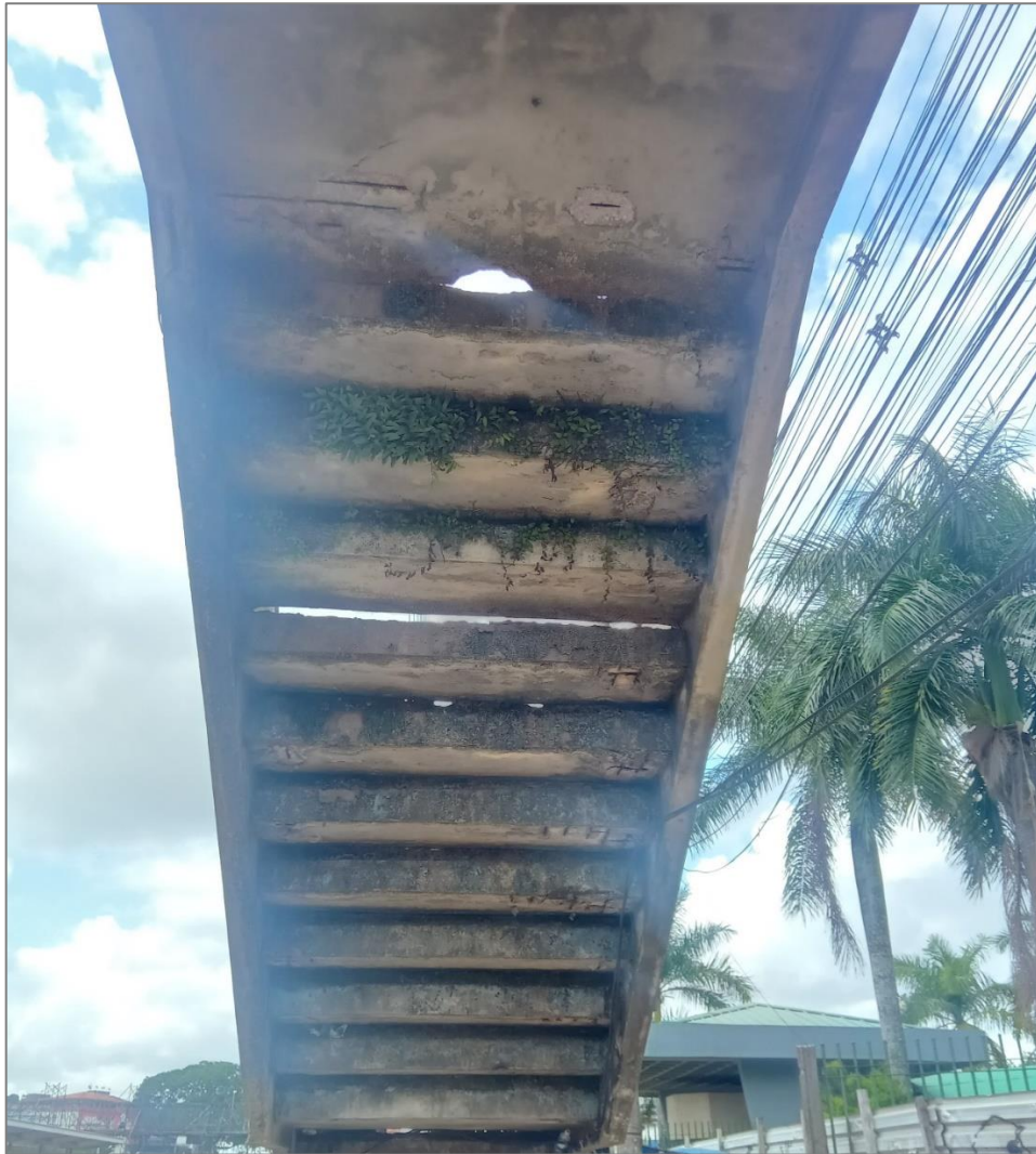
Figura 7 - Passarela Antiga (Vista Inferior)
