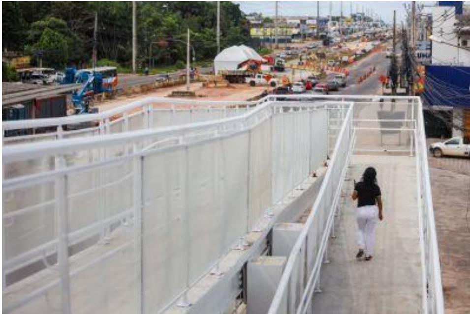
Figura 19 - Nova Passarela instalada (3)
