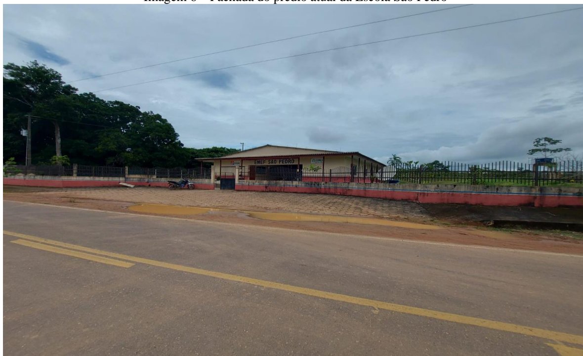
Imagem 6 – Fachada do prédio atual da Escola São Pedro
