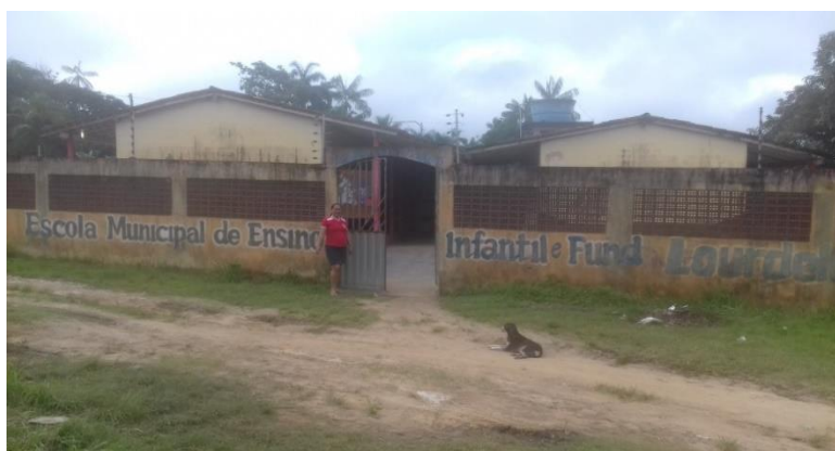
Figura 1: Fachada da escola Municipal Lourdelândia, em Irituia –PA. Fonte: dados da pesquisa
