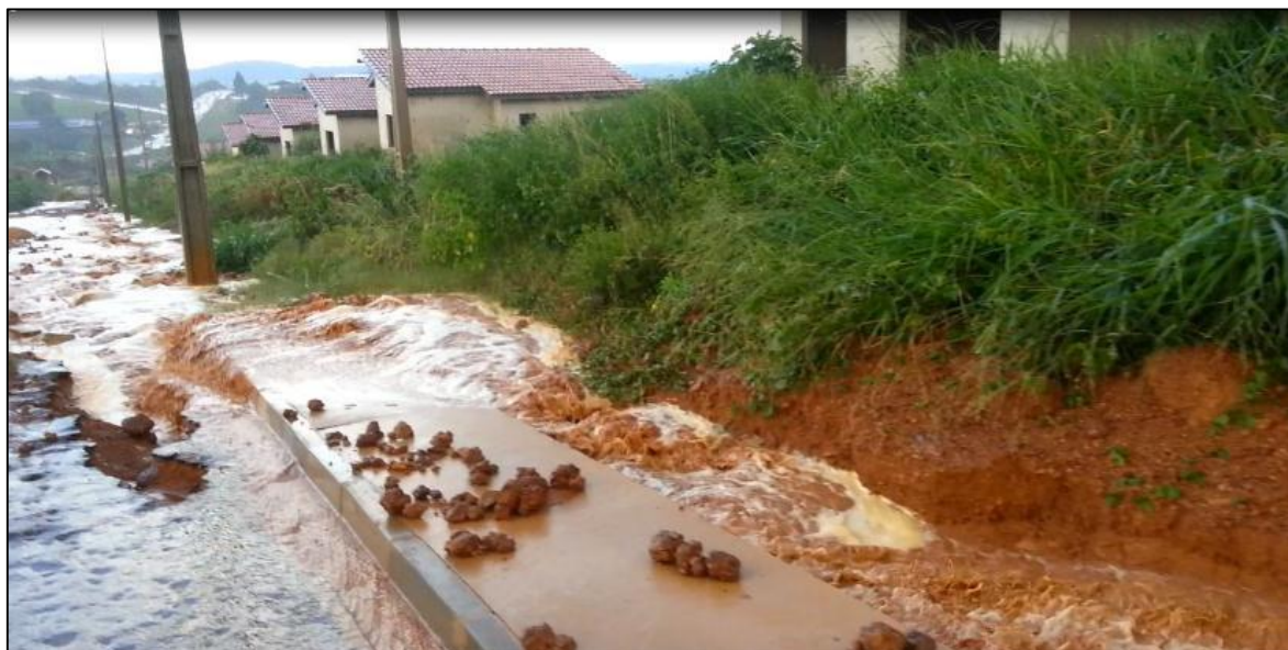
Figura 24 - Escoamento sobre calçada.
