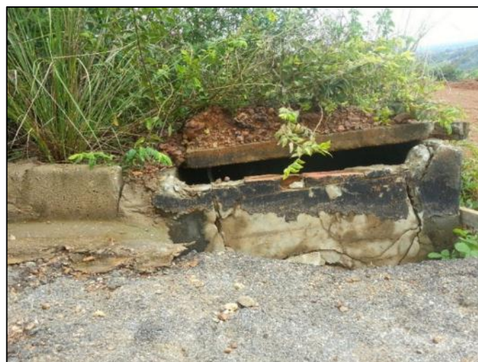
Figura 39 - Boca de lobo com abertura acima do nível da sarjeta.
