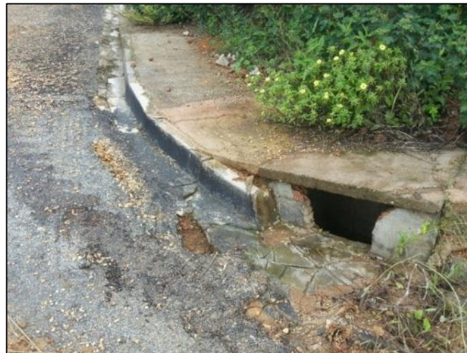
Figura 38 - Boca de lobo em esquina.
