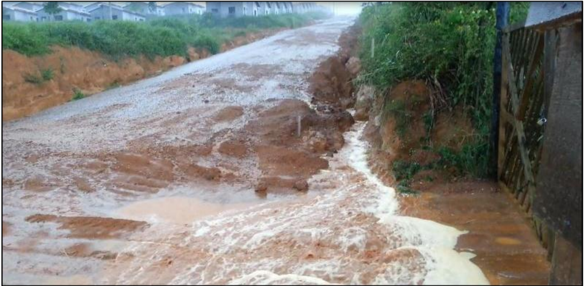
Figura 22 - Escoamento no final de rua.
