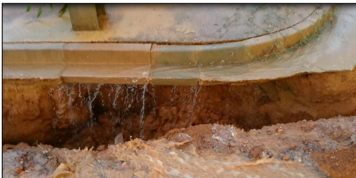
Figura 25 - Sarjetas deterioradas.
