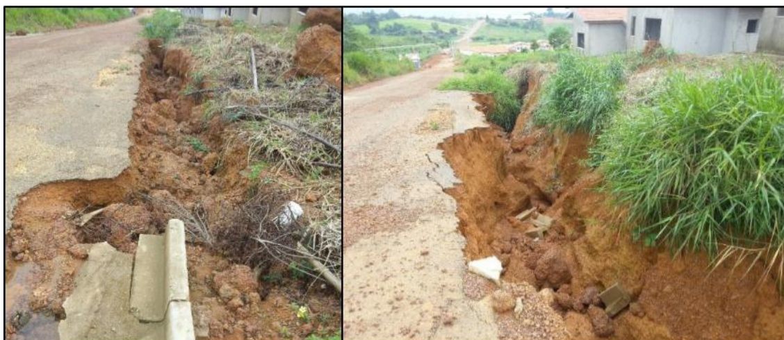
Figura 28 - Sarjetas destruídas.
