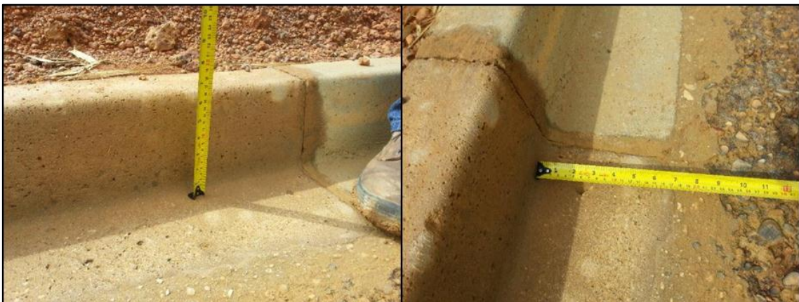
Figura 52 - Sarjeta executada na obra.
