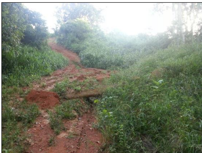
Figura 34 - Ponto exutório do sistema de drenagem.
