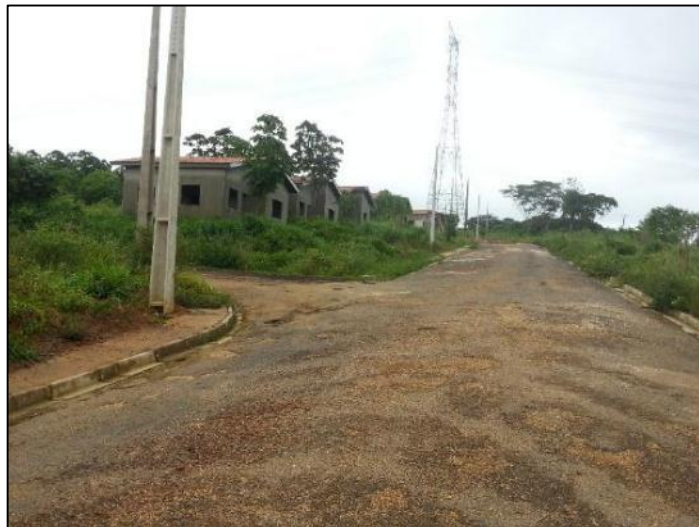
Figura 47 - Inexistência de bocas de lobo.
