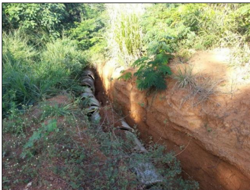
Figura 33 - Exutório destruído.
