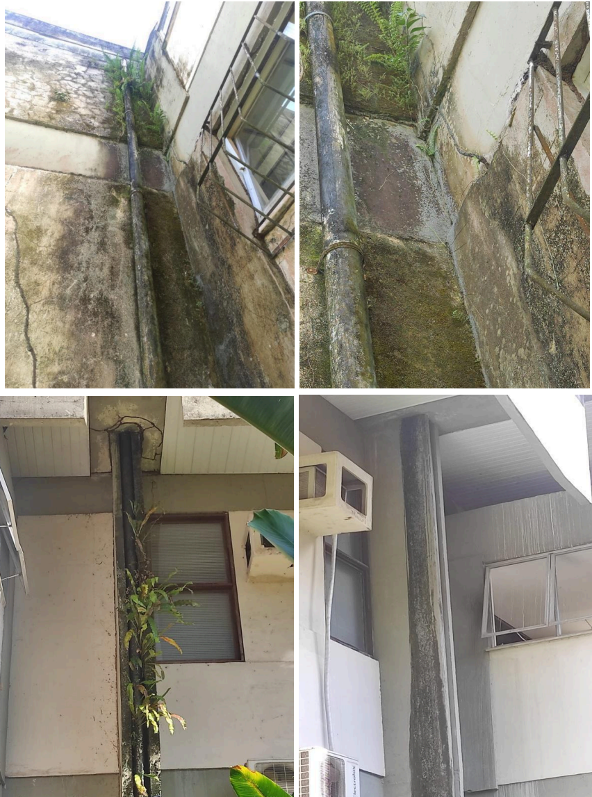
Figura 17 — Infiltrações externas
