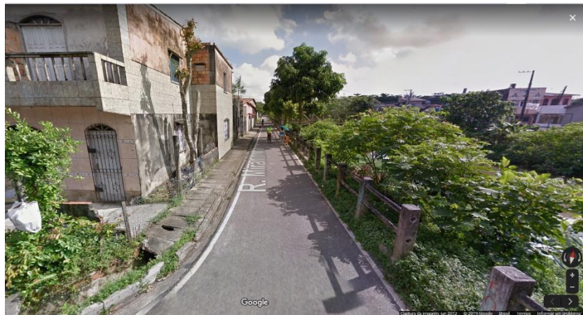
Figura 14: Canal do Jacaré, atualmente as calçadas estão mais degradadas.
