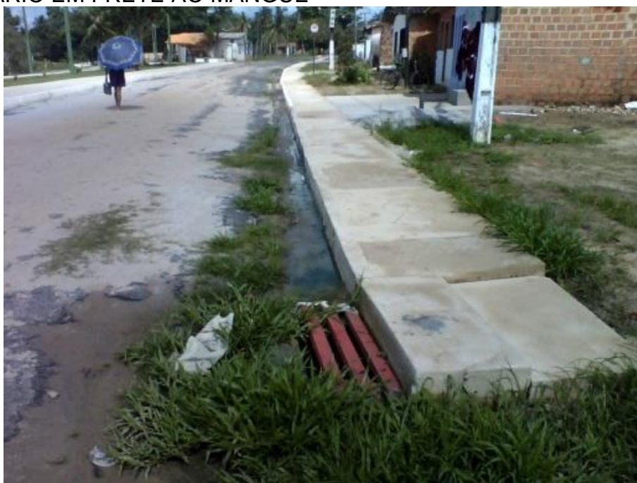
FIGURA 15 - GALERIA NA RUA DO BARRO ALTO RECEBENDO ESGOTO SANITÁRIO EM FRETE AO MANGUE
