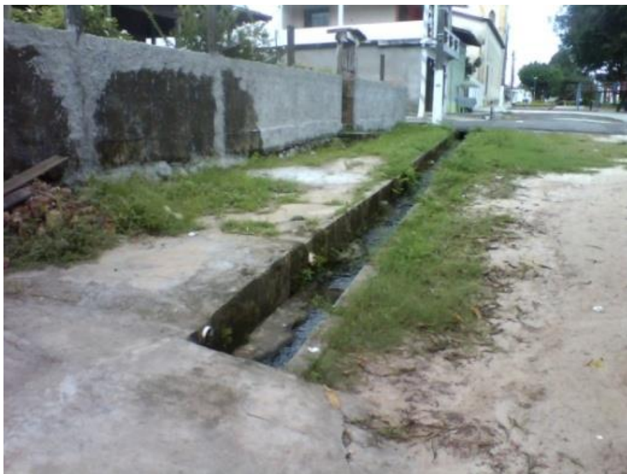
FIGURA 10 - CALÇADA COM VÁRIOS TUBOS DE ESGOTO E ÁGUA PLUVIAL
