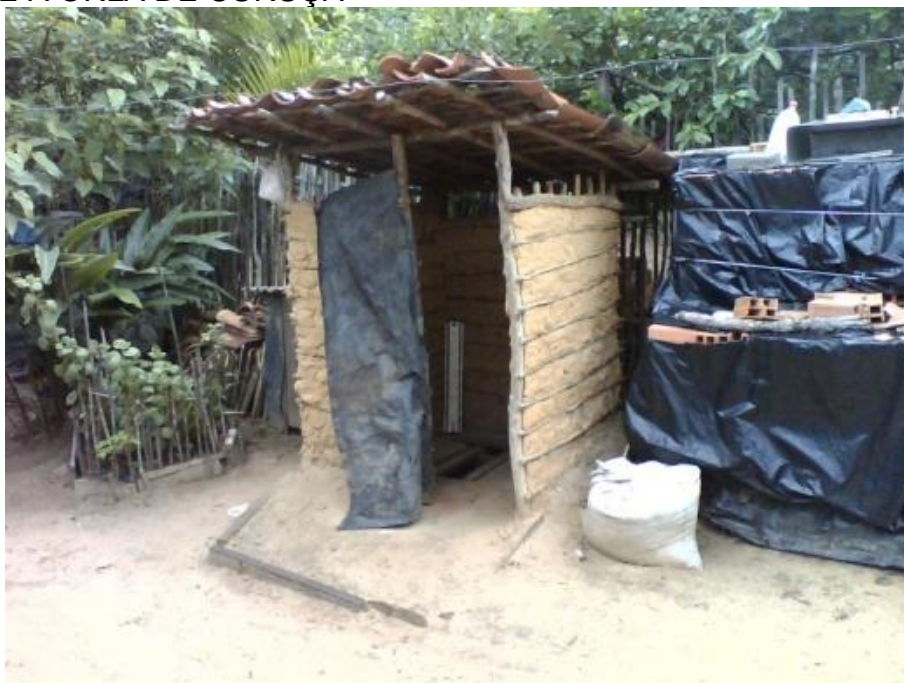
FIGURA 19 - FOSSA SECA EM RESIDÊNCIA DA RUA DO BARRO ALTO EM FRENTE A ORLA DE CURUÇÁ
