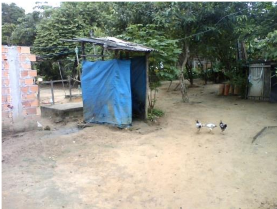
FIGURA 18 - LOCAL DE BANHO EM RESIDÊNCIA NA RUA DO BARRO ALTO
