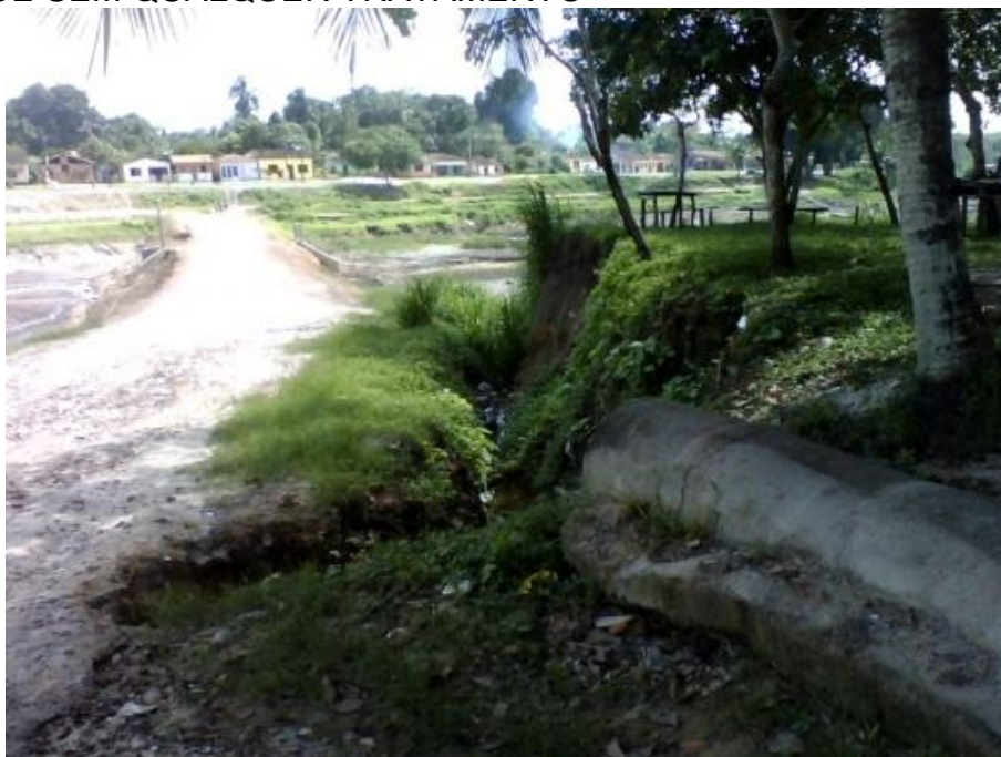
FIGURA 13 - TUBULAÇÃO DESPEJANDO ESGOTO DIRETAMENTE NO MANGUE SEM QUALQUER TRATAMENTO
