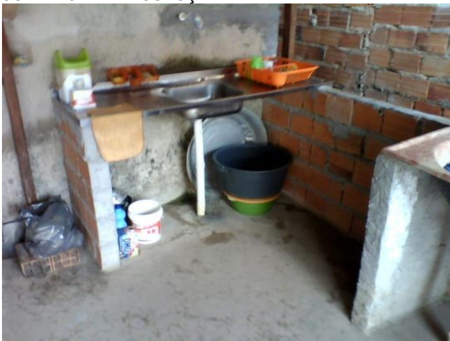
FIGURA 06 - ESTRUTURA SANITÁRIA DE RESIDÊNCIA PRÓXIMA AO MANGUE DA ORLA DE CURUÇÁ
