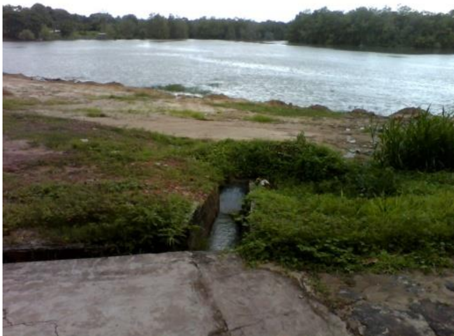
FIGURA 08 - ESGOTO EM DIREÇÃO AO MANGUE DA ORLA DE CURUÇÁ
