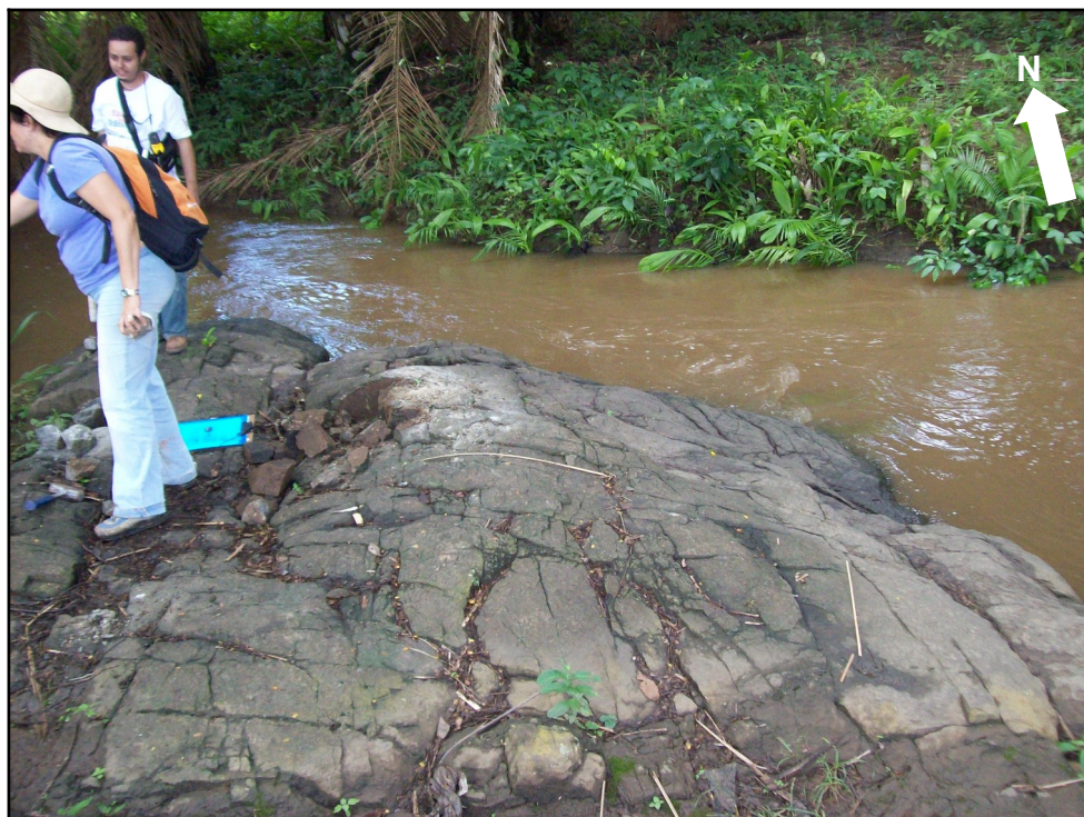
Fig. 08 – Diabásios em lajedo fortemente fraturados nas direções N-S e NW-SE. Ponto AT-2008-ASD/AS-03-B.
