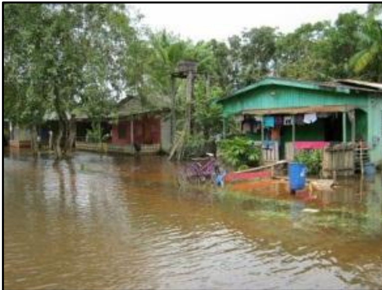
Figura 17 Vista parcial de alagamento em via pública, evidenciando a frente das residências afetadas. Fonte: http://www.amapadigital.net/galeria.php?ID=23 . Acesso em: 10/05/2012.
