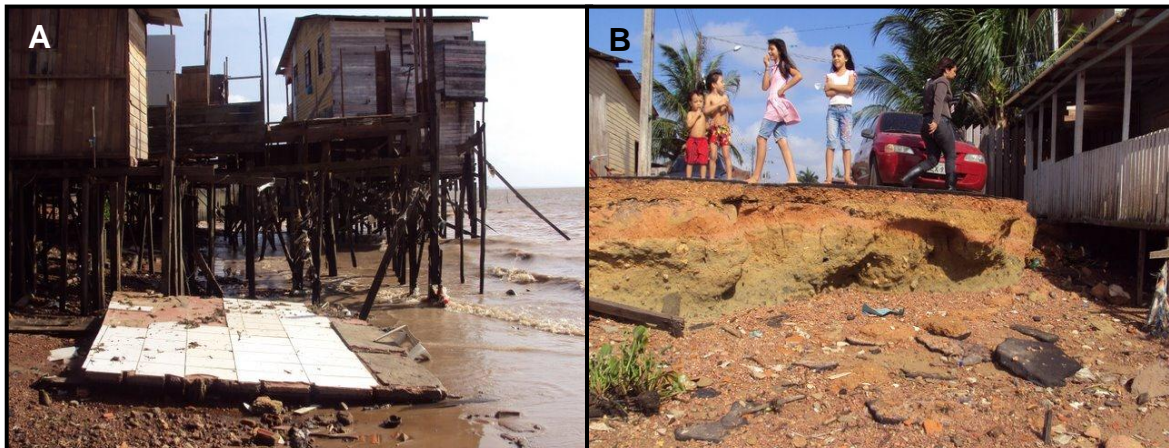
Figura 7 Edificação as margens do Rio Amazonas sucumbe a força das águas (A) e moradores vivendo próximos a áreas de risco, evidenciadas pelo fenômeno das “terras caídas” (B).
