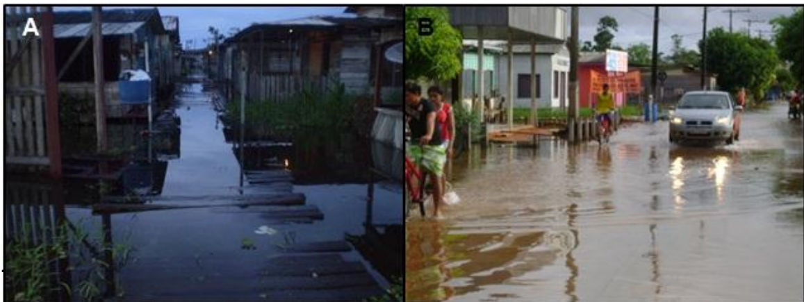
Figura 31 Edificações de madeira construídas sobre pontes de madeira conferindo estrutura de palafita (A) e via pública submersa (B).
