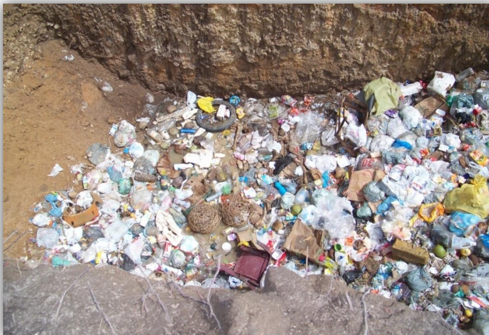
Figura 13 - Células com a presença de lixo e água no aterro controlado de Soure (PA) – 2010
