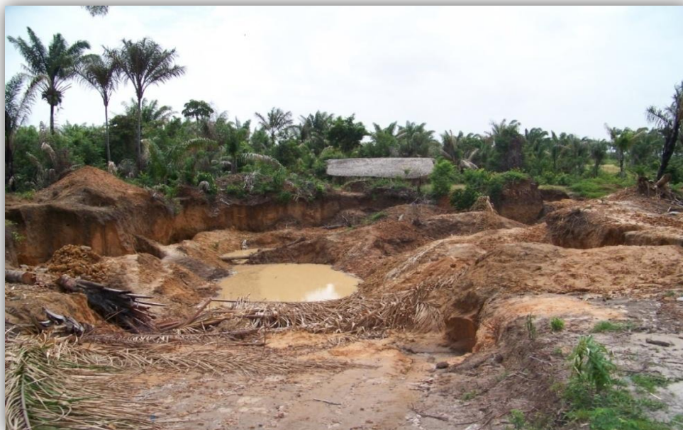
Figura 14-Cava realizada para a retirada de piçarra e pedra na área do aterro controlado de Soure (PA)-2010.
