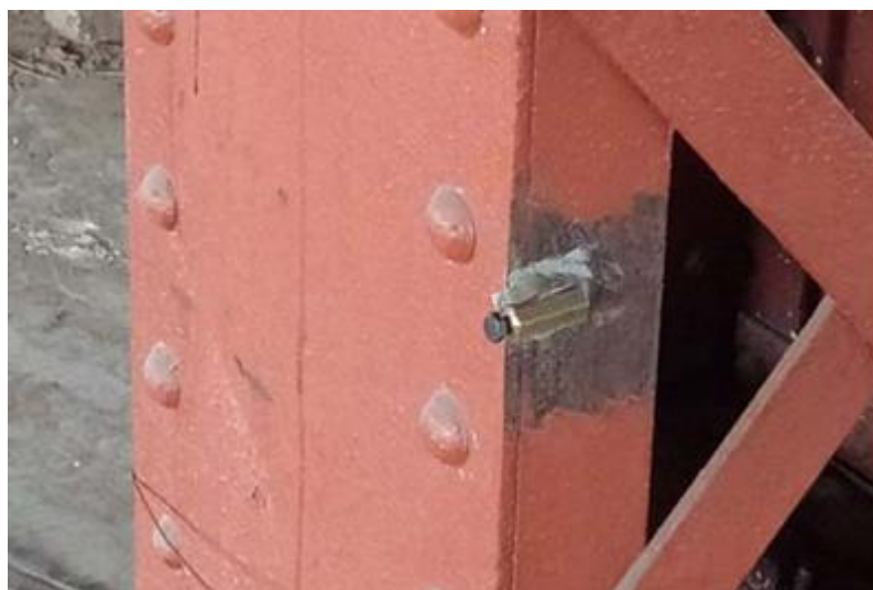
Figura 18: Detalhe do pino de leitura de recalque.
