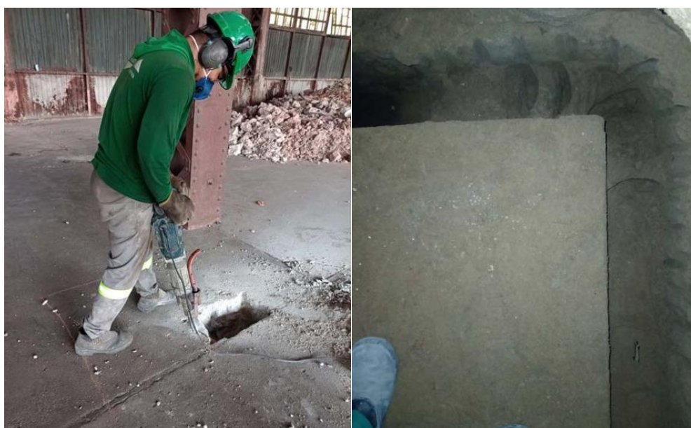
Figura 12: Verificação das fundações existentes.
