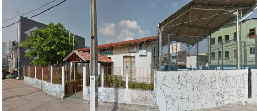
Foto 18 - Fachada da Escola Municipal Amância Pantoja, Belém-PA.
