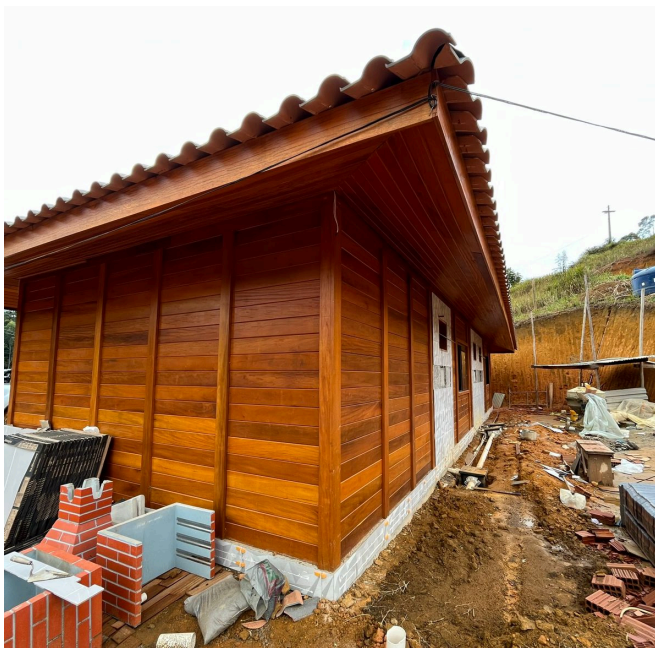
Figura 09 — Exemplo de casa de madeira utilizando encaixe de tábuas.
