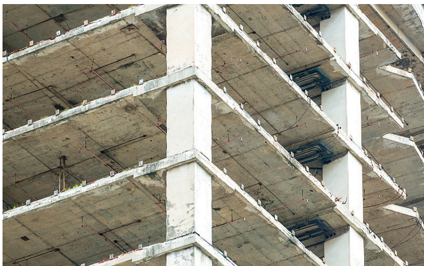
Figura 10 — Estrutura com lajes planas.
