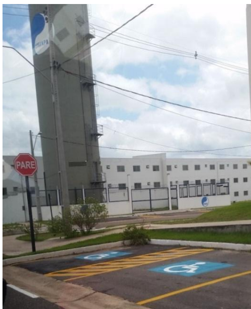
Figura 15 - Captação de Água (COSANPA).
