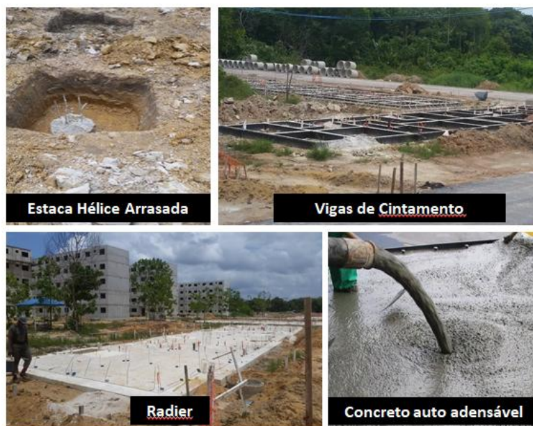
Figura 6 - Estaca hélice arrasada, vigas de cintamento, radier e concreto auto adensável.
