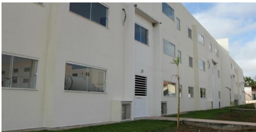
Figura 7 - Bloco de apartamentos – Novo Cristo I.
