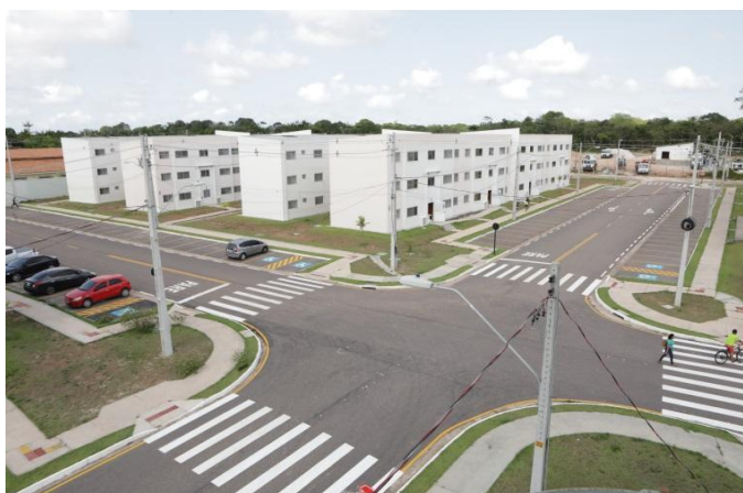
Figura 14 - Pavimentação e Iluminação.
