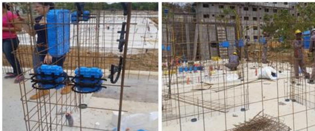
Figura 28 - Componentes elétricos e malha de aço.
