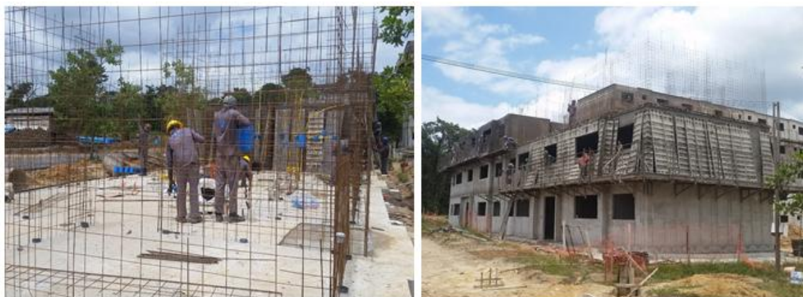
Figura 5 - Armação das paredes em concreto armado.
