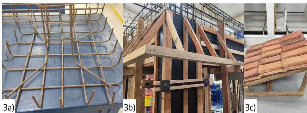
Figura 3 - 3a: Montagem de armadura para fundação; 3b: Montagem de formas em escala real; 3c: Estrutura amostral de telhados cerâmicos.
