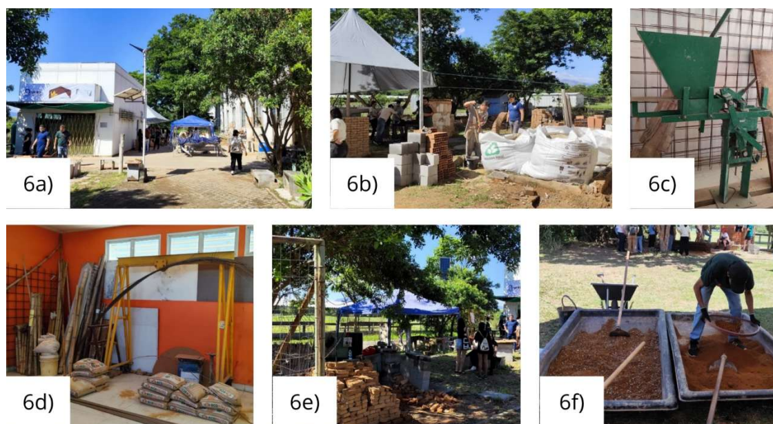
Figura 6 – 6a: Protótipo e depósito de materiais; 6b: Canteiro PC3; 6c: Maquinário para tijolos de BTC; 6d: Interior do protótipo; 6e: Canteiro PC2; 6f: Processo de separação da granulometria de areia.
