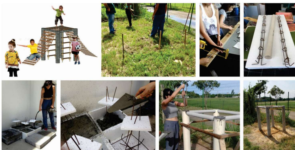
Figura 7 - Processo construtivo do mobiliário do brinquedo infantil.
