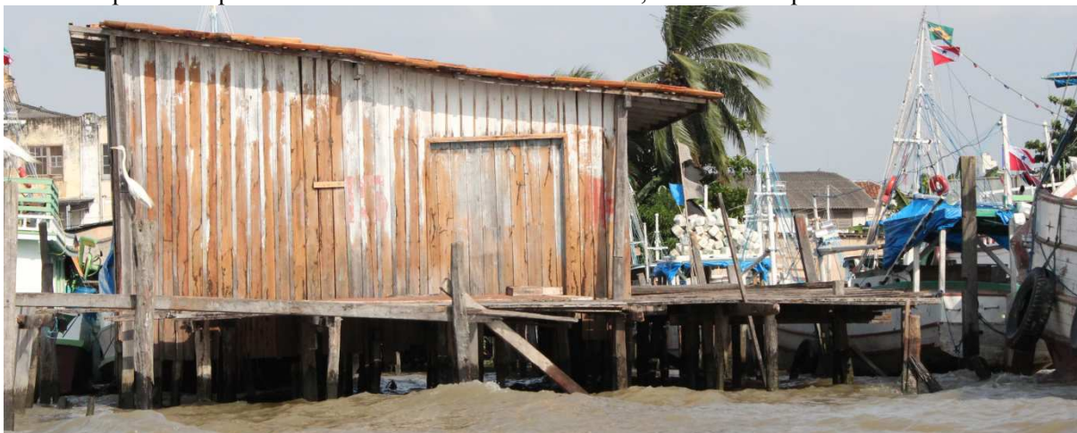
Fotografia 11 - No final de "corredor de casas" em espaço invadido entre a área do Porto Brilhante e área do porto e posto de abastecimento Vasconcelos, de frente para o Beco do Carmo.
