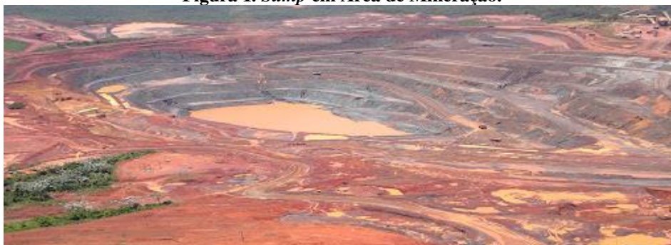
Figura 1. Sump em Área de Mineração.
