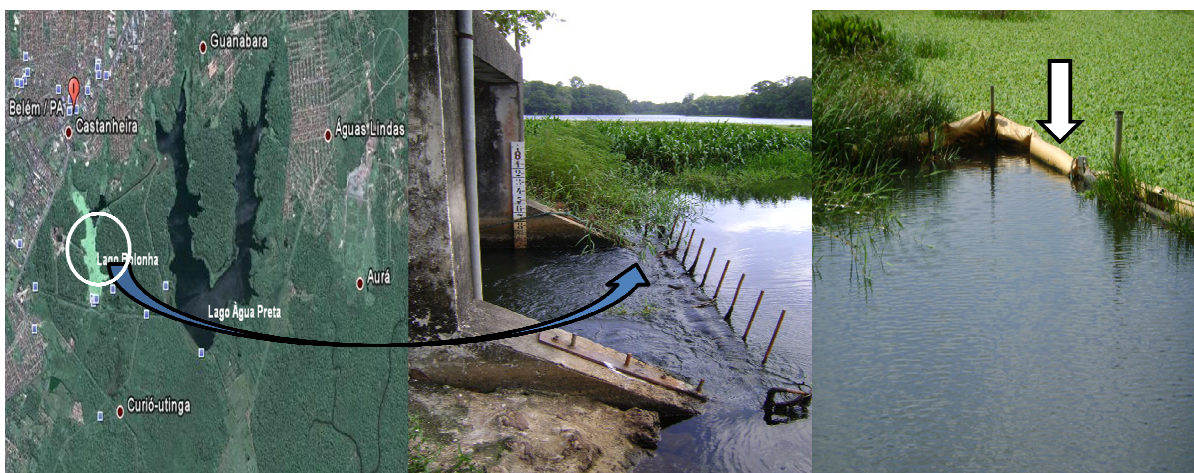
Figura 13: Imagens da entrada da ETA do lago Bolonha. Fonte: PESQUISA DE CAMPO, 2010; GOOGLE EARTH, 2010.
