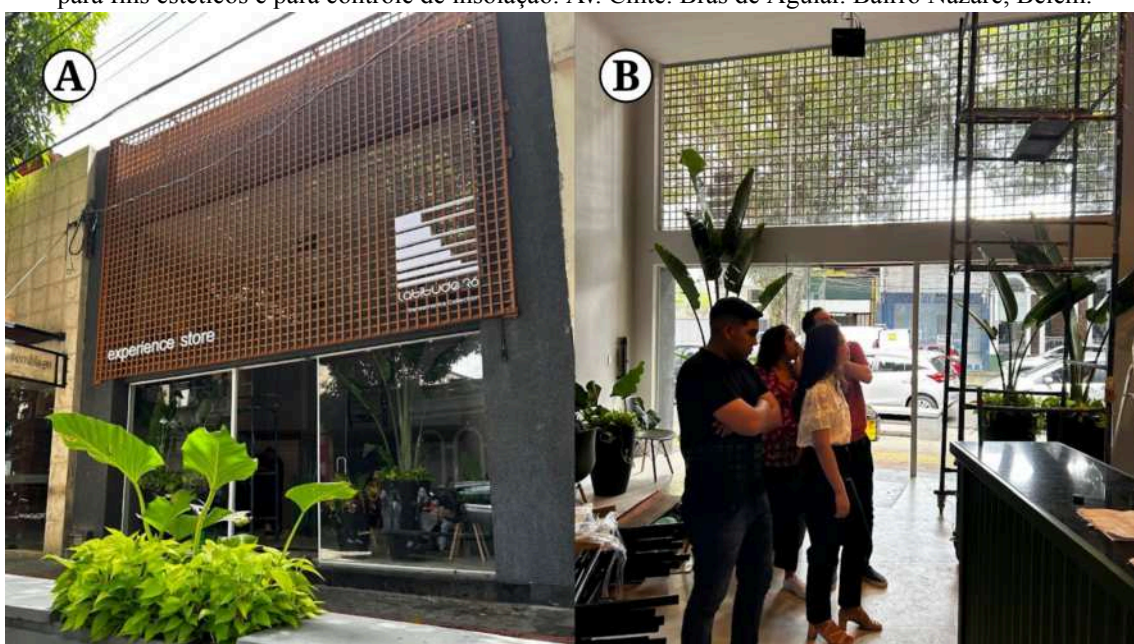
Figura 16 - Fachada de estande de vendas para um condomínio, que se utilizou de muxarabis de metalon para fins estéticos e para controle de insolação. Av. Cmte. Brás de Aguiar. Bairro Nazaré, Belém.
