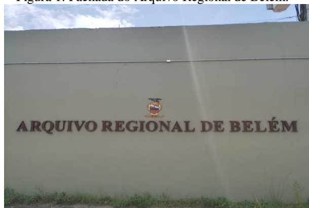
Figura 1: Fachada do Arquivo Regional de Belém.
