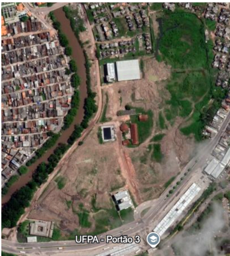
Figura 20 – Campus III após a última intervenção executada
