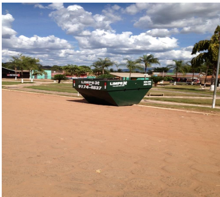
Figura 26 - Container disponibilizado para armazenamento e coleta de resíduos de construção Fonte: SAAEX, 2013
