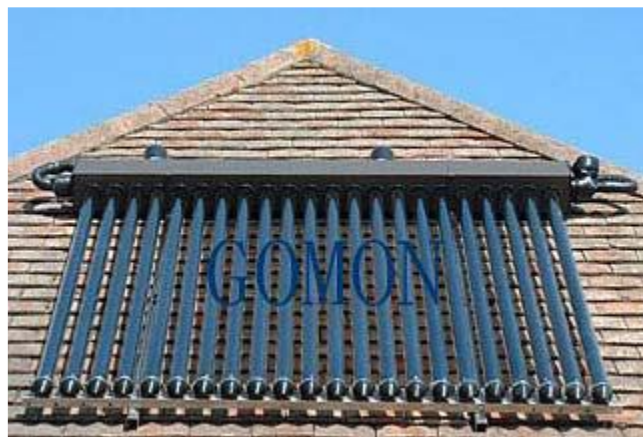
Figura 12 – Exemplos de Coletores Solares de Tubos Evacuados Fonte: Rede Brasil de capacitação em aquecimento solar, 2009
