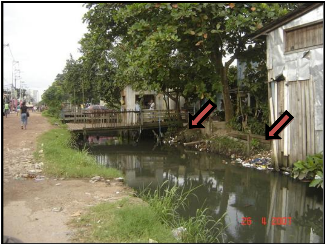
FIGURA 30 – Foto ilustrando as condições do canal de drenagem da Rua Caripunas decorrente do efeito antrópico. As setas vermelhas indicam a acumulação de dejetos às margens do canal.
