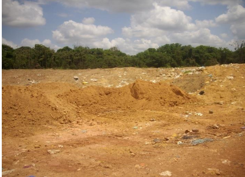
Figura 9- Escavação de uma célula para a disposição do lixo no aterro de Abaetetuba- (PA)
