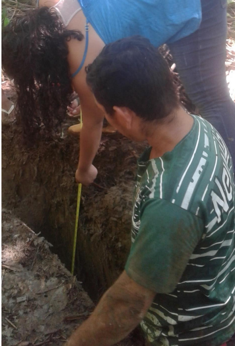
Figura 14- Imagem real dos registros das medidas do desnível do solo
