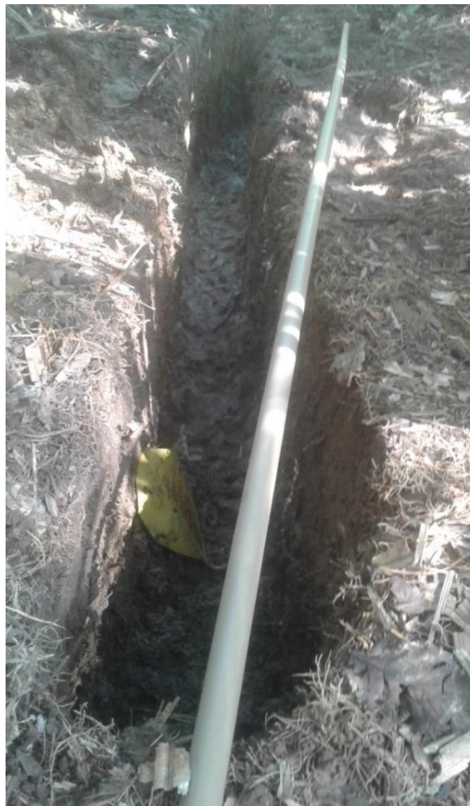
Figura 13 —Imagem real da abertura do solo para entrada da tubulação de alimentação
