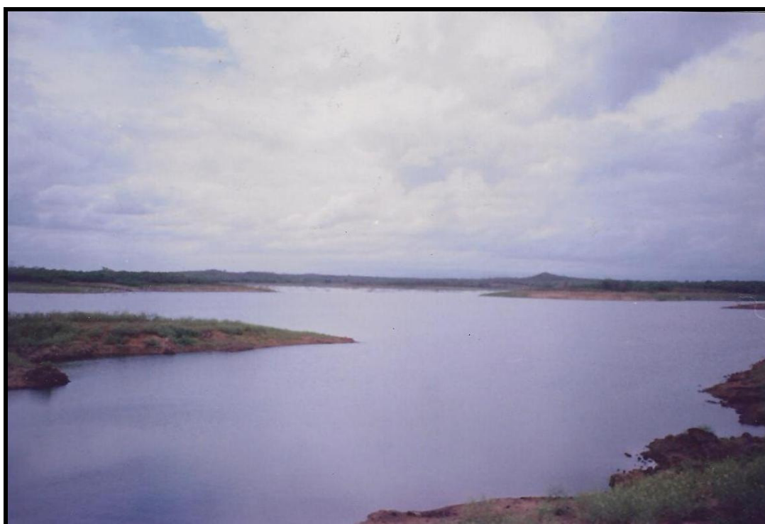
FIGURA 22 – Vista panorâmica do Açude Aires de Souza.
