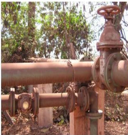
Figura 21: Medidor de vazão - entrada (2006)
