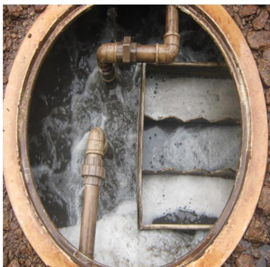
Figura 26: Decantador lamelar do sistema da ETE compacta (2007).
