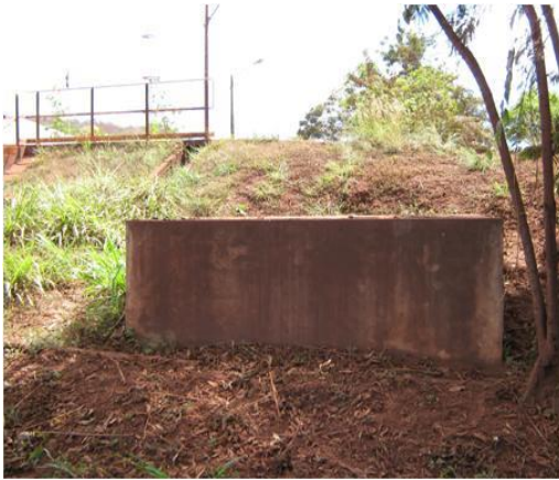
Figura 31: Caixa de gordura de concreto (2007).
