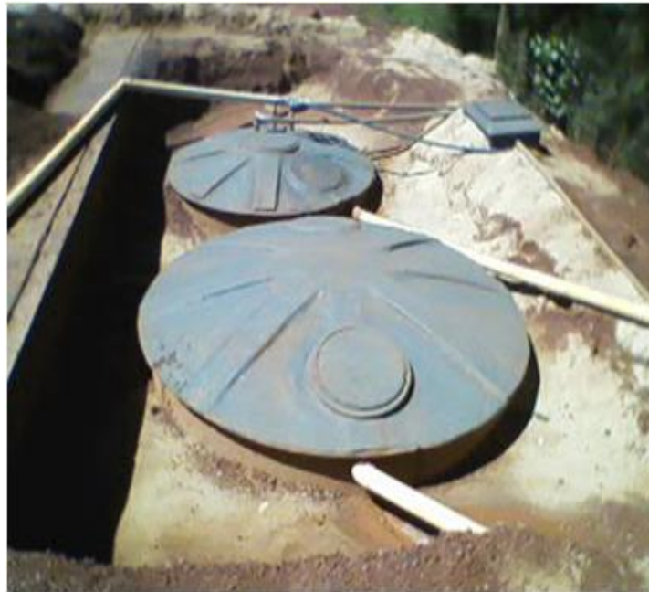
Figura 36: Estação elevatória da ETE de polimento (2009).
