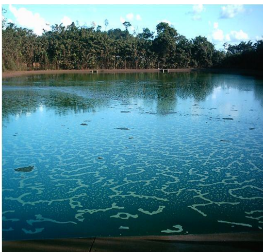
Figura 8 – Lagoa de estabilização (2003)
