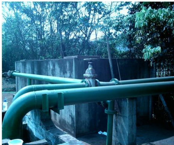
Figura 12: Tubulação de entrada da ETE da Mina de N4 (2004).
