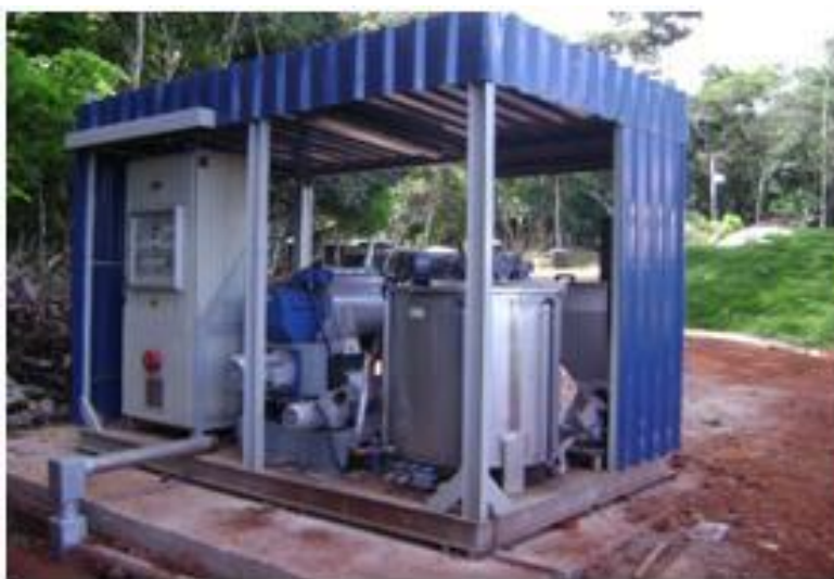
Figura 33: Centrífuga de lodo das ETE's de Carajás sugerido pela Fundação Bio Rio (2008).
