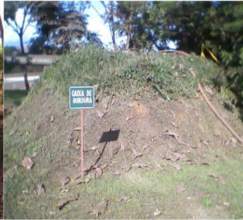
Figura 32: Caixa de gordura metálica (2007).
