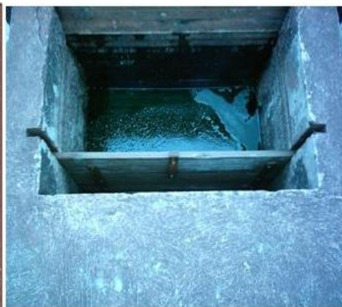
Figura 14: Nova comporta da saída (2004).
