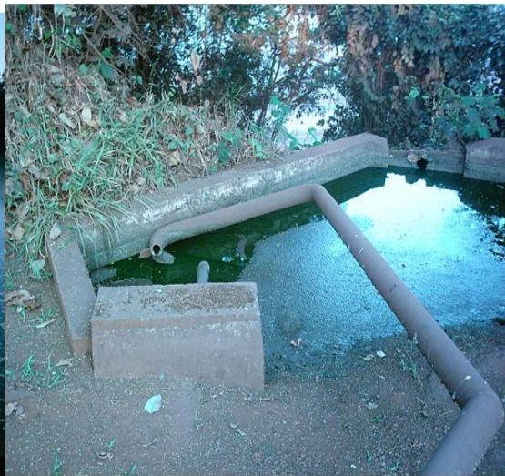
Figura 9 – Caixa de descarga (2003).
