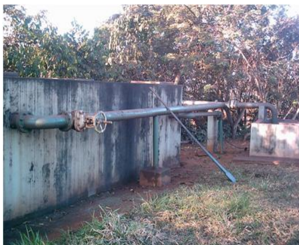
Figura 11: Caixa de gordura da ETE da Mina de N4 (2004).
