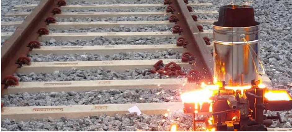
Figura 15 – Processo de soldagem aluminotérmica em trilho.
